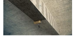
Aplicación de adhesivo
